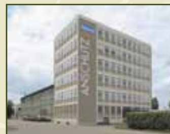
ANSCHÜTZ-Werk in Ulm, Württemberg. ANSCHÜTZ factory in Ulm, Germany.
